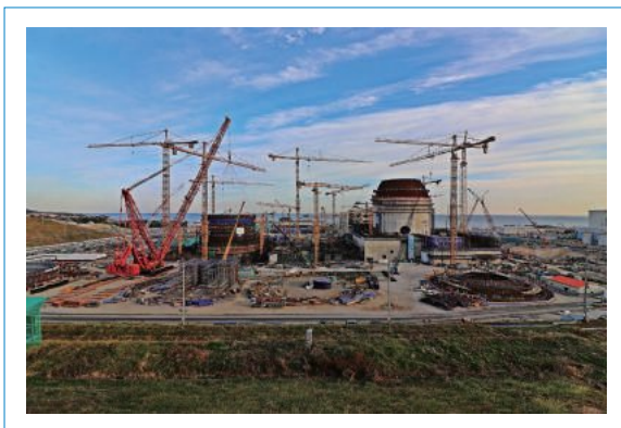
[ 신고리 5·6호기 시공공인검사 현장 ]
